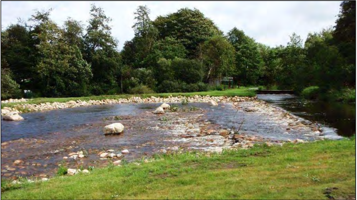
Figur 3-3 Fotoet viser et eksempel på et bredt overløbsareal med strømrende og overløbskant. Indløbet til stryget ses i højre side af fotoet.
