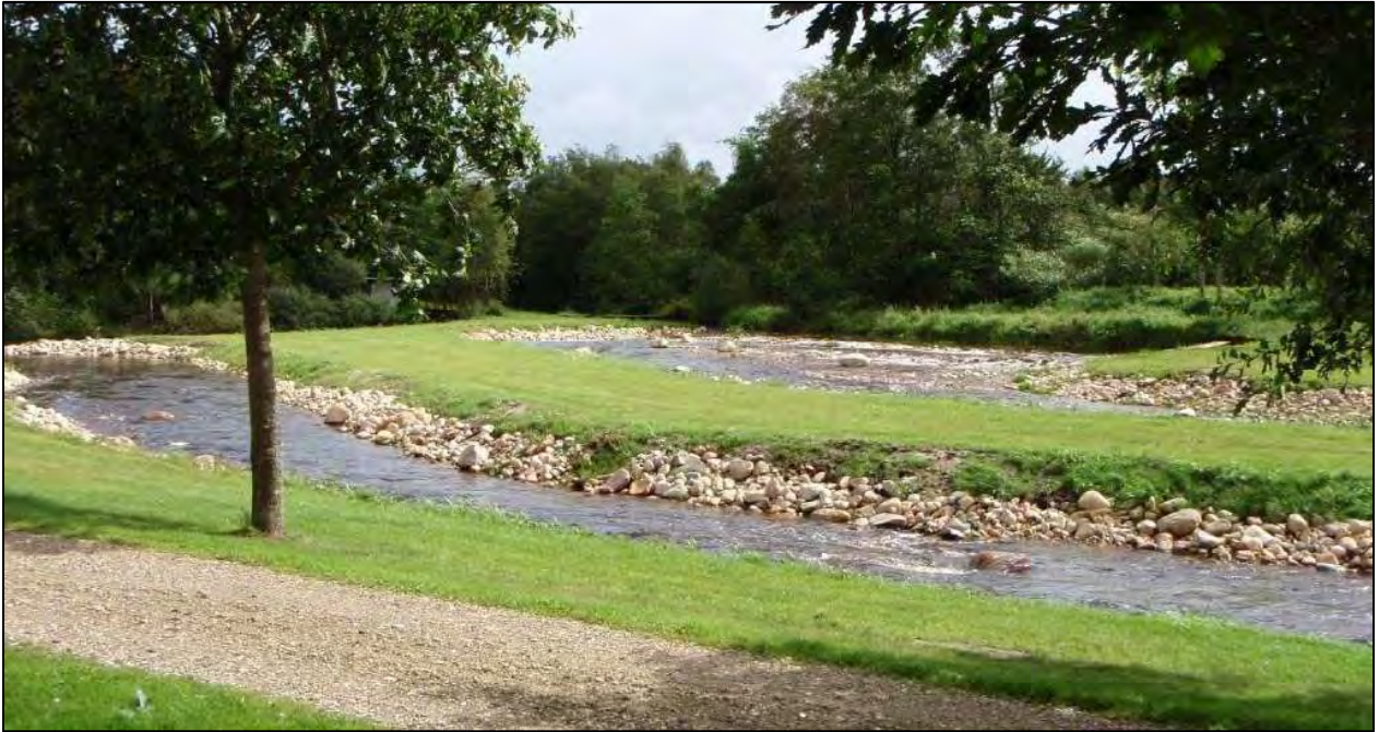
Figur 3-4 Eksempel på et slynget omløbsstryg gennem et parklignende område. I baggrunden ses indløbspartiet og overløbsarealet.
