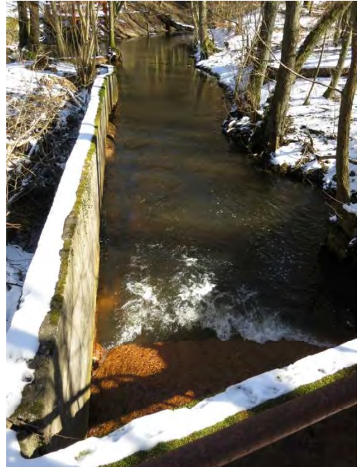
Figur 4-3 Fotoet er taget fra betonbroen umiddelbart opstrøms sammenløbet ved turbineanlægget.
