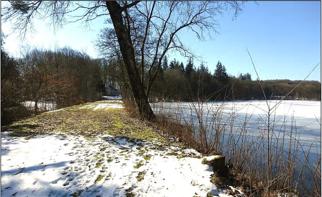
Figur 3-2 Fotoet viser dæmningen set fra nord imod syd. Den projekterede spunsvæg vil således ligge få meter ude i søen i fotoets højre side.
